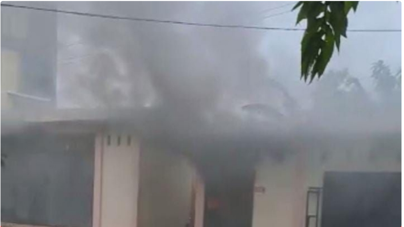
Mesin genset RSUD Lanto Daeng Pasewang Kabupaten Jeneponto diduga terbakar
